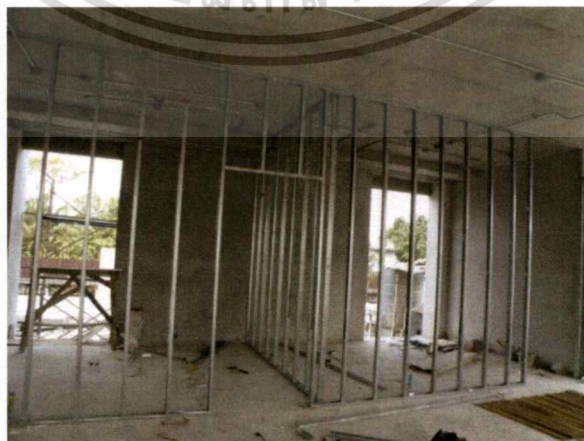
ภาพที่ 7-7 การติดตั้งผนังเบาในอาคาร
