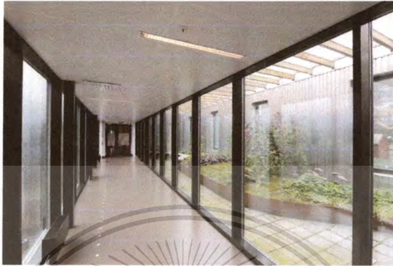
รูปที่ 3.28 ภาพบรรยากาศภายในโครงการที่สามารถมองเห็นพื้นที่สีเขียวภายนอกได้จากการใช้วัสดุโปร่งในการออกแบบ
