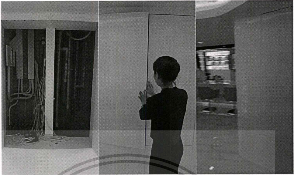
ภาพที่ 3.12 ช่องงานระบบที่ถูกออกแบบให้กลมกลืนไปกับผนัง
