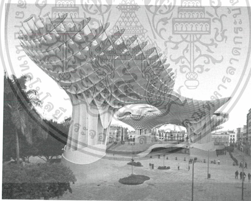
รูปภาพ 7 - 9 ระบบโครงสร้างแบบ Waffle/Grid
