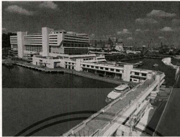
ภาพที่ 4.38 แสดงทางเดินเชื่อมระหว่างอาคารผู้โดยสารสู่ท่าเรือสำหรับเรือ Ferry และ Cruise มีลักษณะยาวลงไปทะเลจนไปเทียบด้านข้างของเรือ (ที่มา : https://www.singaporecruise.com.sg )
