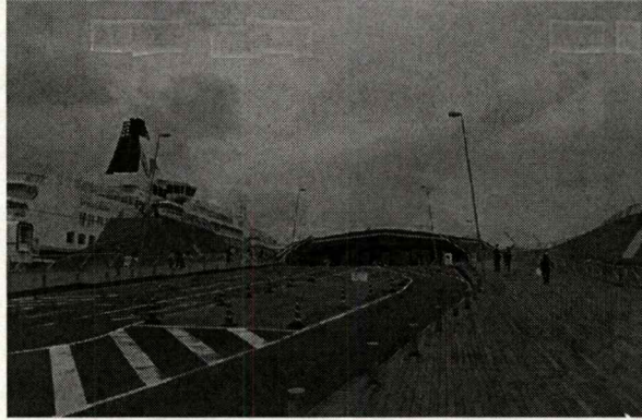
ภาพที่ 4.20 แสดงบริเวณทางเข้าด้านหน้าอาคาร Yokohama International Passenger Terminal พื้นผิวทางเดินไม่ถูกปรับระดับให้อยู่เท่ากับถนน ก่อนที่จะค่อยๆ เลี้ยวไปคลุมพื้นที่ส่วน ดาดฟ้าของอาคาร (ที่มา : http://www.scgbuildingmaterials.com )
