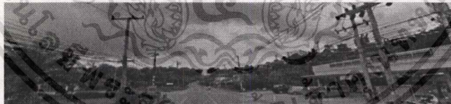
ภาพที่ 3.5 แสดงเส้นถนนหลักก่อนเข้าโครงการ รูปแบบทางหลวง 2 ช่องจราจรที่มีระยะทางรวม 10 เมตร ตัวถนนกว้าง 7 เมตรและไหล่ทางกว้างข้างละ 1.5 เมตร (ที่มา : สำนักงานเจ้าท่าภูมิภาคที่ 5,2560 )
