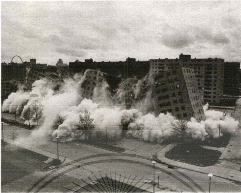
รูปที่ 3- 9 ภาพเหตุการณ์การระเบิดรื้อถอน โครงการ
