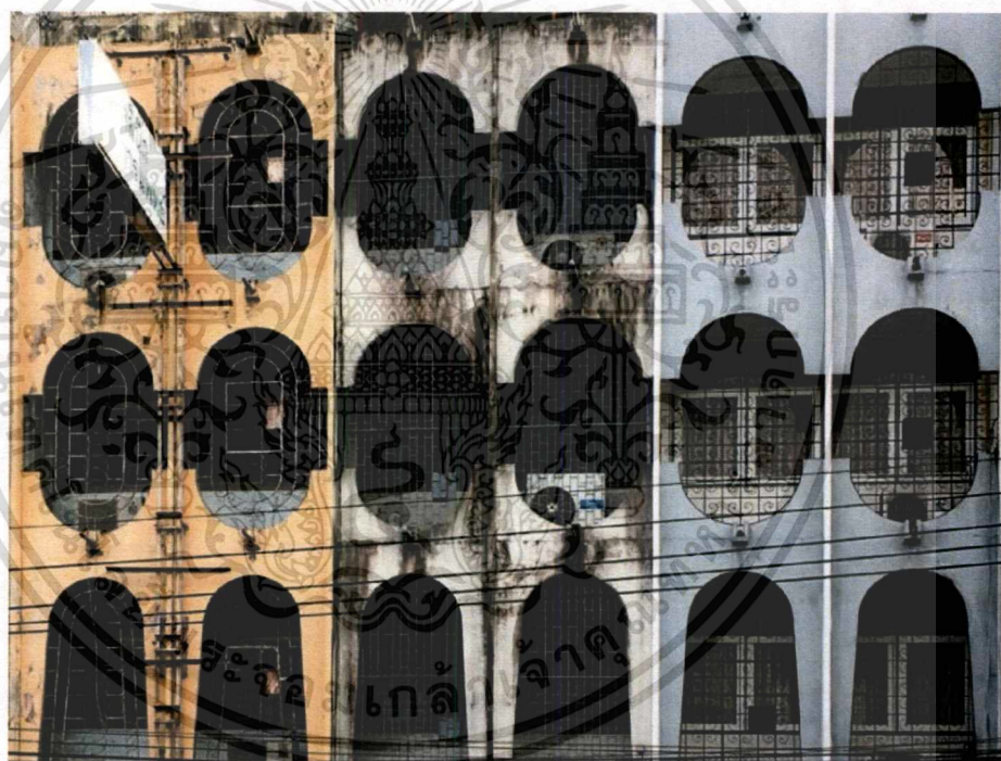
ภาพที่ 2.4 หน้าต่างเหล็กคัตจากอาคารตึกแถว
