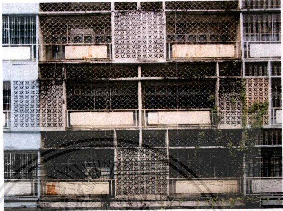
ภาพที่ 2.6 เหล็กคัตจากอาคารตึกแถว
