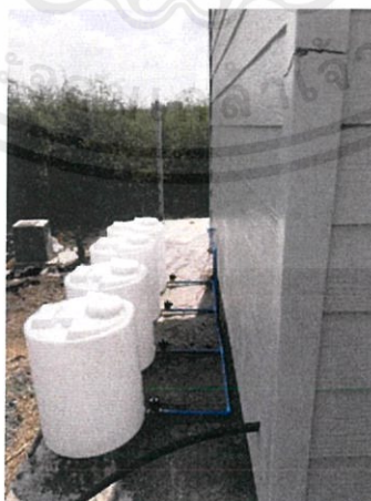
รูปที่ 4.2 การติดตั้งถังปุ๋ยเพื่อเตรียมการผสม
