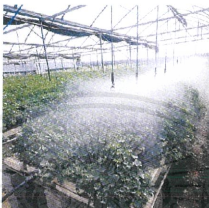
รูปที่ 2.10 การใช้ระบบพ่นหมอกในโรงเรือน
