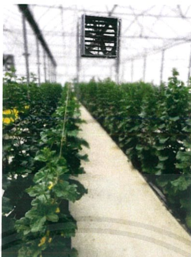
รูปที่ 2.8 การใช้พัดลมระบายอากาศในโรงเรือน
