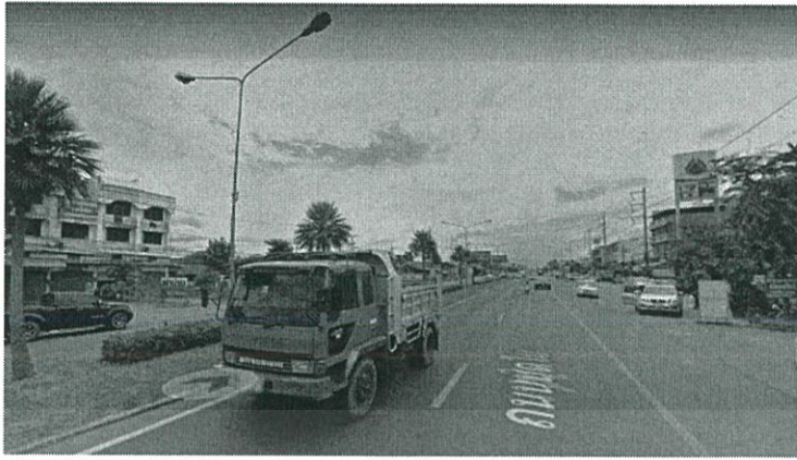
รูปที่ 3.7 ถนนสาย 22 อำเภอเมือง จังหวัดอุดรธานี (4 ช่องจราจร ติดตั้งเกาะกลาง โคมไฟกิ่งคู่)
