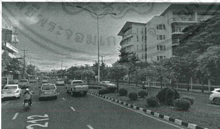
รูปที่ 3.9 ถนนสาย 24 อำเภอเมืองอุบลราชธานี (6 ช่องจราจร ติดตั้งเกาะกลาง โคมไฟกิ่งคู่)
