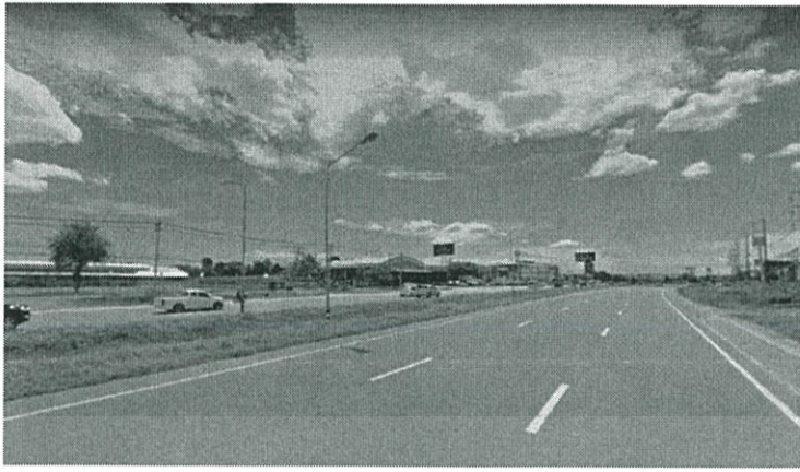
รูปที่ 3.10 ถนนสาย 36 อำเภอเมือง จังหวัดระยอง (6 ช่องจราจร ติดตั้งเกาะกลาง โคมไฟกิ่งเดียว)
