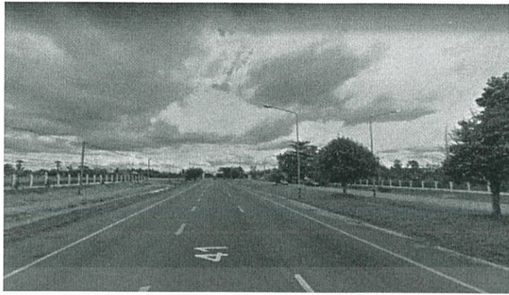
รูปที่ 3.13 ถนนสาย 41 อำเภอเมือง จังหวัดพัทลุง (6 ช่องจราจร ติดตั้งเกาะกลาง โคมไฟกิ่งเดียว)
