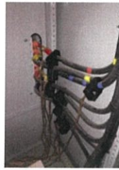
รูปที่ 4.1 การติดตั้งหม้อแปลงกระแส
