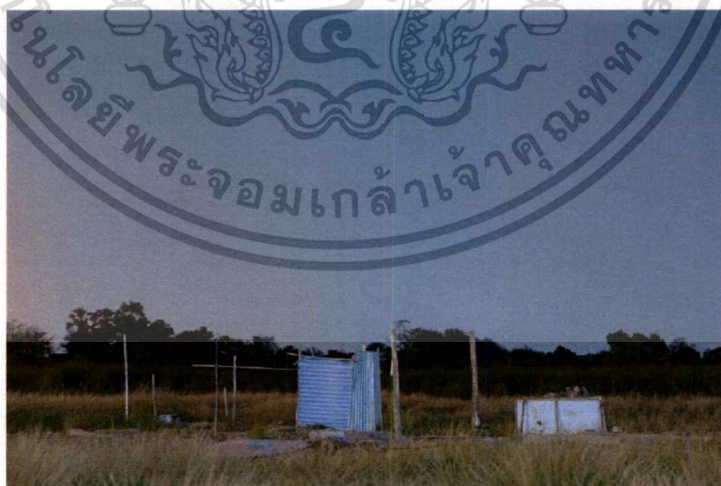
ภาพที่ 3.6 ภาพโครงการที่ 2 ชั้นที่ 1
