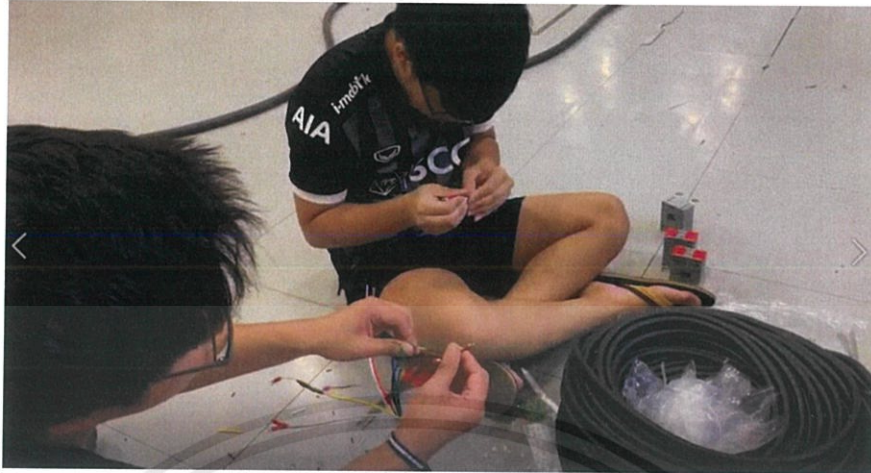
รูปที่ 3.3 ปอกสายไฟเพื่อนำมาใช้ในการเดินสายไฟ
