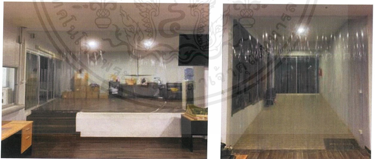
รูปที่ 3.16 ติดตั้งพลาสติกใส PVC สำหรับกันความเย็น
