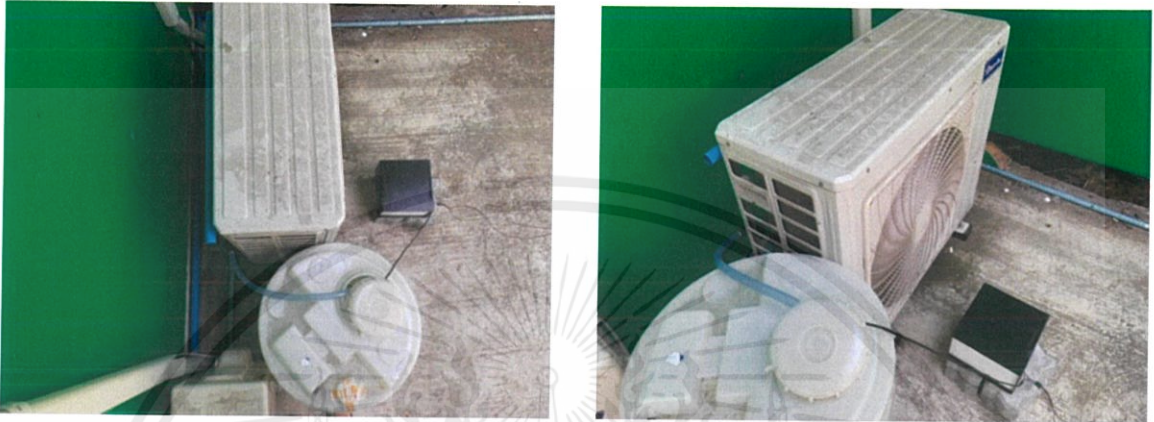
รูปที่ 3.14 ติดตั้งอุปกรณ์ที่คอยล์ร้อนของเครื่องปรับอากาศ
