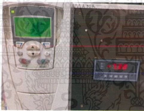
รูปที่ 4.15 อุปกรณ์ไทรฟ์ที่ใช้ในการควบคุมภาระทางกลของมอเตอร์เหนี่ยวนำ
