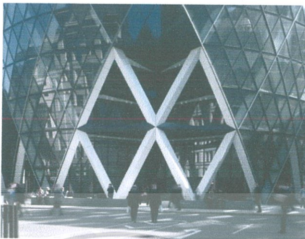
รูปที่ 3-36 แสดงโครงสร้างภายนอกอาคาร 30 St. Mary Axe
