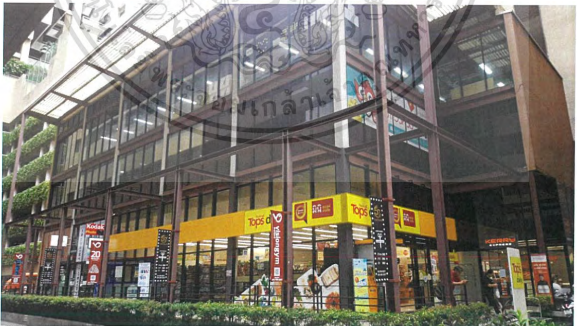
รูปที่1.8 แสดงพื้นที่ด้านหน้าและด้านข้างของอาคาร
