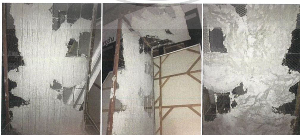
ภาพที่ 3.15 ชั้น โครงเหล็ก ปั้นปูน
