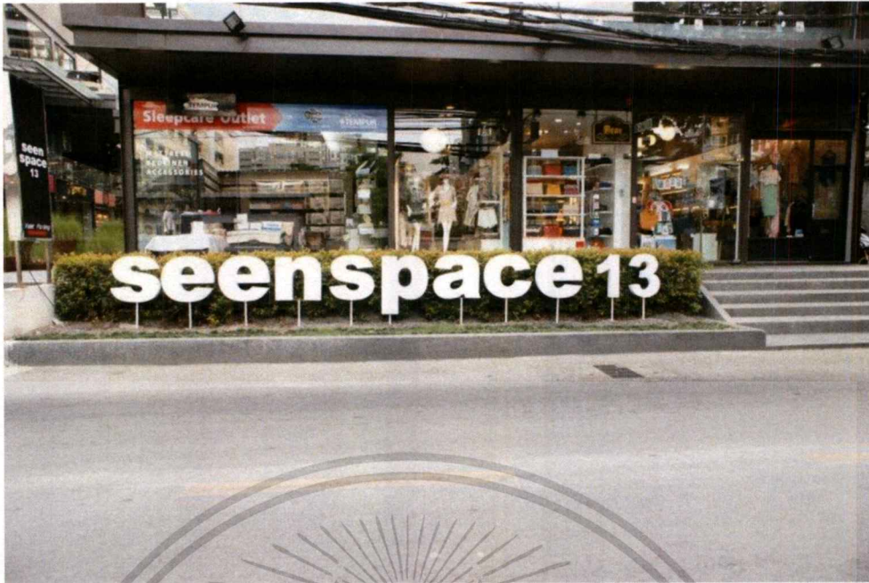
รูปที่ 1.28 แสดงภาพบริเวณด้านหน้าอาคาร
