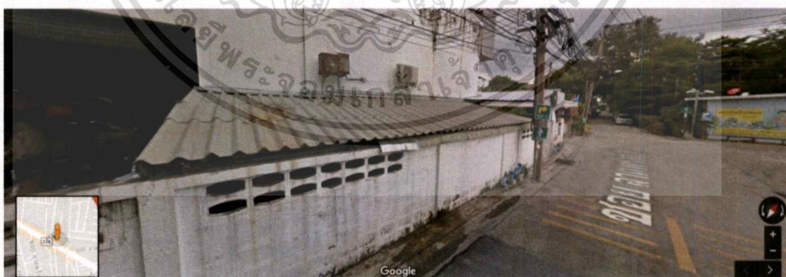
รูปที่ 1.26 แสดงสภาพแวดล้อมที่ตั้งปัจจุบัน (บริเวณทิศตะวันออกที่ติดกับถนนในซอยลาดพร้าว 93)
