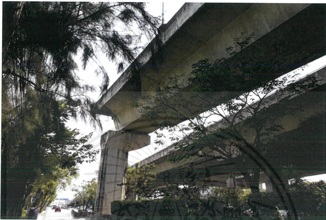
รูปที่ ค.1 สํารวจรอยต่อพื้นที่โครงการ
