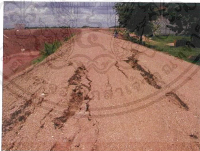
รูปที่ 2.14 รอยแยกเนื่องจากหน่วยแรงดึงในดินเหนียว
