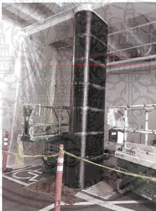
รูปที่ 2.4-3 การพอกโครงสร้างเสาและคานที่มีอยู่เดิมด้วยวัสดุคอมโพสิตประเภทพอลิเมอร์เสริมเส้นใย
