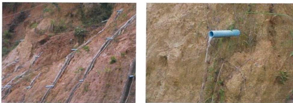
รูปที่ 2.27 การฝังท่อน้ำออกจากราดดินบริเวณริมถนนอวามมลา จ.ภูเก็ต (ผศ.ดร. ธนาตล คงสมบูรณ์ ,2547)
