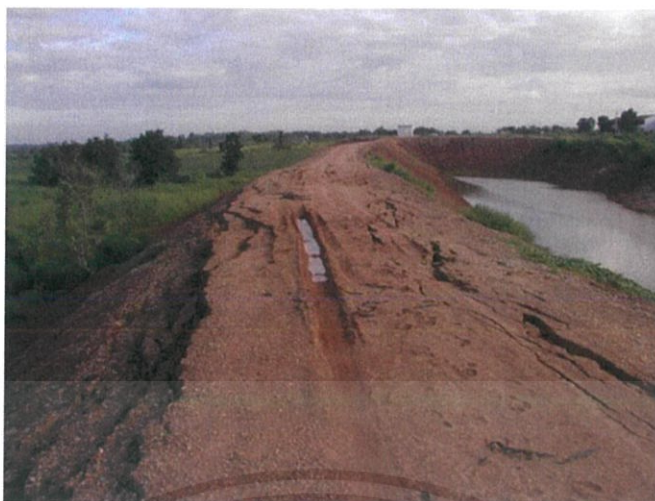
รูปที่ 2.11 คันดินมีเสถียรภาพลดลงเนื่องจากน้ำหนักของยานพาหนะที่เคลื่อนที่บนคันดิน (ผศ.ดร. พรพจน์ ต้นเส็ง ,2554)
