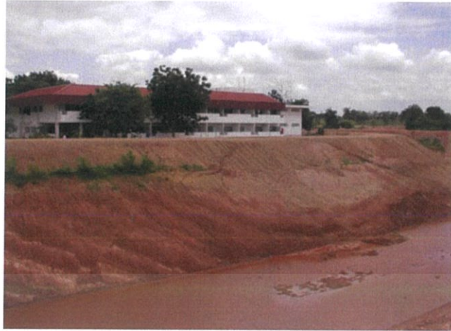
รูปที่ 2.9 ลักษณะชั้นดินอ่อนเอียงตัวแทรกอยู่ในดินเหนียวแข็งซึ่งเป็นสาเหตุทำให้คันดินเกิดการวิบัติ (ผศ.ดร. พรพจน์ ตันเส็ง ,2554)
