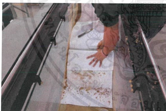
รูปที่ 3.24 การปูแผ่นใยสังเคราะห์
