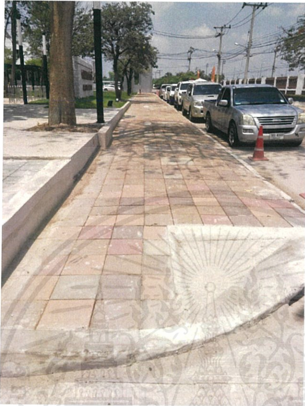
รูปที่ 4.16 ทางเท้าคนพิการ
