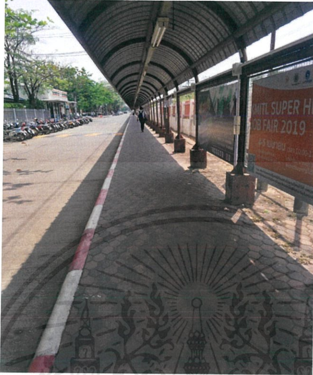
รูปที่4.14 ทางเท้าใกล้รางรถไฟ
