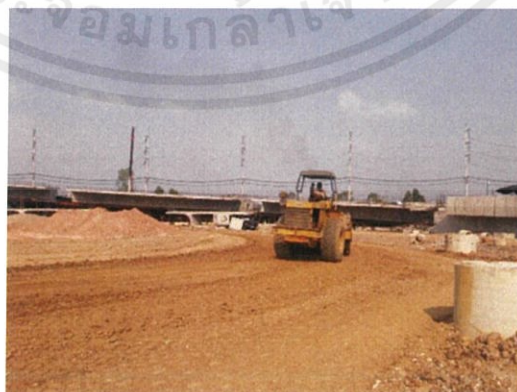
รูปที่ 2.23 ดินถมที่ควบคุมคุณภาพการบดอัด [http://www.overpassaran.com]
