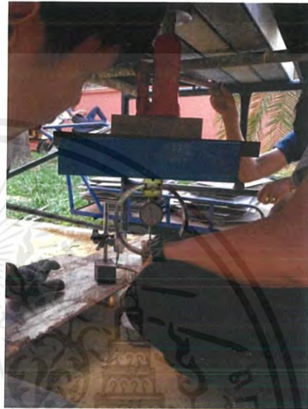
รูปที่ 3.8 รูปการติดตั้งอุปกรณ์ ในการทดสอบ Field C.B.R.
