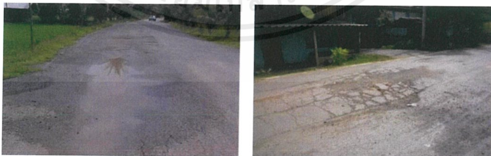
รูปที่ 2.4 ความเสียหายประเภทยุบตัวпенแอ่ง
