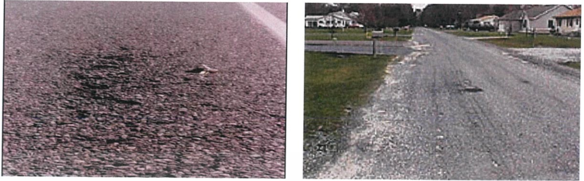
รูปที่ 2.14 ความเสียหายประเภทผิวทางหลุมร่อน
