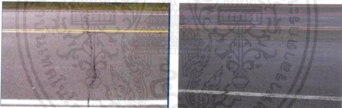
รูปที่ 2.19 ความเสียหายประเภทรอยแตกกราวตามแนวขวาง
