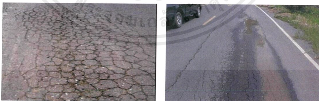
รูปที่ 2.21 ความเสียหายประเภทรอยแตกกราวแบบหนังจระเข้
