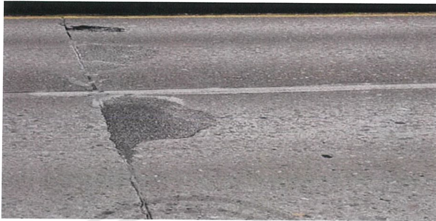
รูปที่ 2.32 ความเสียหายผิวทางคอนกรีตประเภทรอยปะซ่อมที่เสียหาย การวัดพื้นที่ความเสียหายประเภทรอยปะซ่อมที่เสียหาย โดยให้ดำเนินการวัดพื้นที่เป็น สี่เหลี่ยม และ ขยายออกจากพื้นที่เสียหายด้านละ 30 เซนติเมตร ตัวอย่างดังแสดงในรูปที่ 2.33
