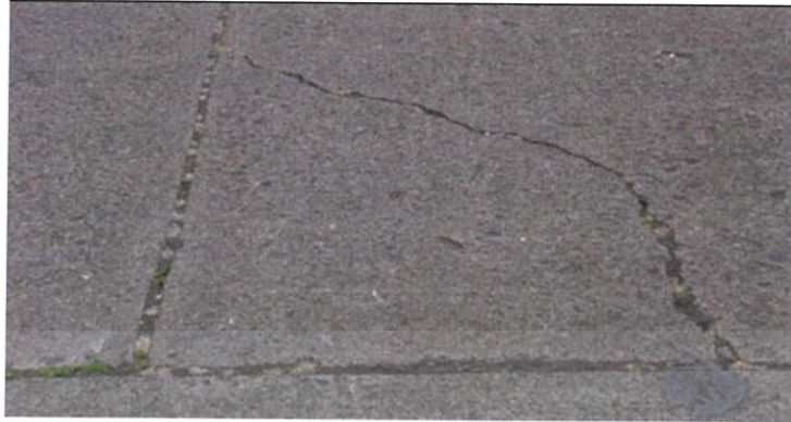
รูปที่ 2.30 ความเสียหายผิวทางคอนกรีตประเภทรอยแตกตามมุม
