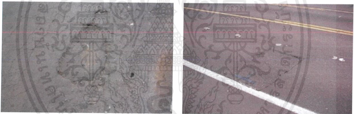
รูปที่ 2.11 ความเสียหายประเภทรอยปะซ่อมที่เสียหาย
