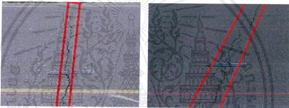
รูปที่ 2.20 ตัวอย่างการวัดปริมาณความเสียหายประเภทรอยแตกตามยาว / ขวาง
