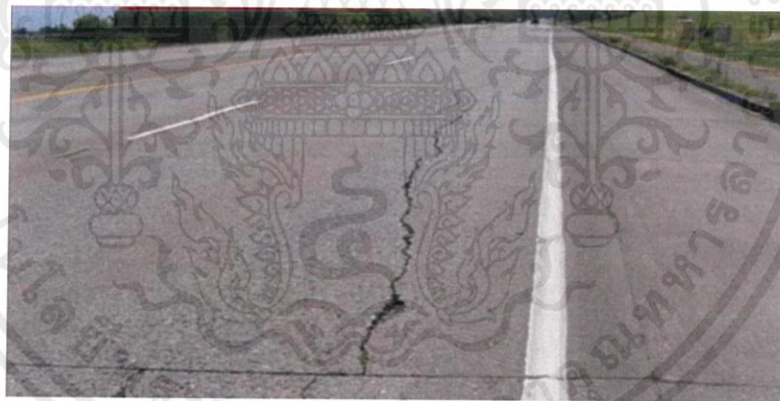
รูปที่ 2.25 ความเสียหายผิวทางคอนกรีตประเภทรอยแตกตามยาว
