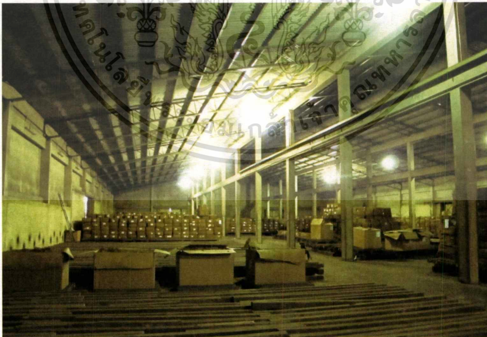
รูปที่1.11 ภายในอาคารเก็บพัสดุโรงงานยาสูบ
