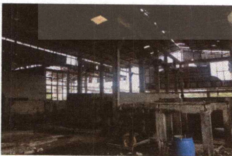
รูปที่ 4.14 แสดงทัศนียภาพภายในโกดังโรงน้ำแข็งหลังที่2 ด้านหลัง โครงสร้างเสาปูน
