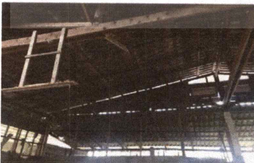
รูปที่ 1.39 แสดงทัศนียภาพภายในโกดังโรง น้ำแข็งหลังที่ 1 โครงสร้างไม้ เปิดช่องแสง
