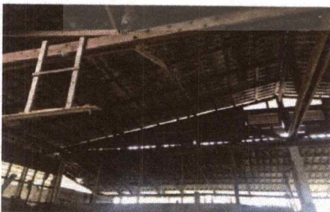
รูปที่ 4.8 แสดงทัศนียภาพภายในโกดังโรงน้ำแข็งหลังที่ 1 โครงสร้างไม้ เปิดช่องแสง
