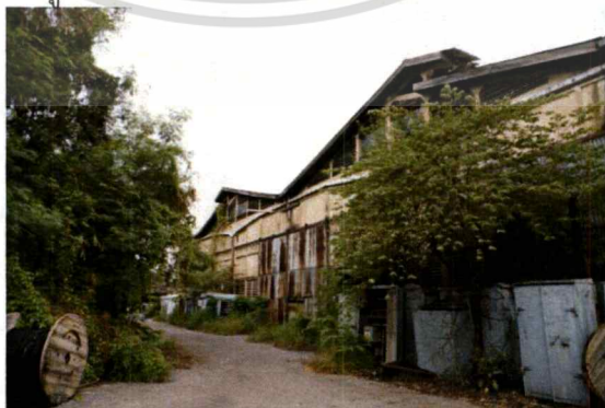
รูปที่4.4 ภายนอกอาคารโกดังเก็บคลังพัสดุ 1
