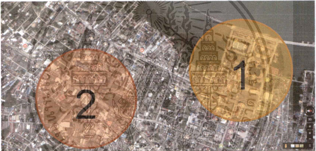
ภาพที่ 6-1 แสดงทำเลตำแหน่งที่ตั้งโครงการ 2 ทำเล
