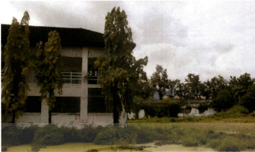
รูปภาพที่ 3.12 แสดงมุมมองภายในโครงการ กำแพงเรือนจำ ถ่ายเมื่อวันที่ 17 ตุลาคม พ.ศ.2560
