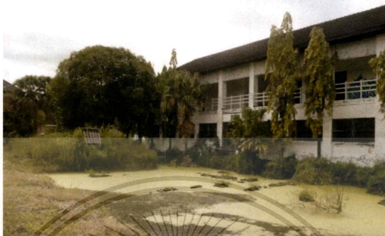
รูปภาพที่ 3.9 แสดงมุมมองภายในโครงการ เรือนเครื่องฟ้า ถ่ายเมื่อวันที่ 17 ตุลาคม พ.ศ.2560
