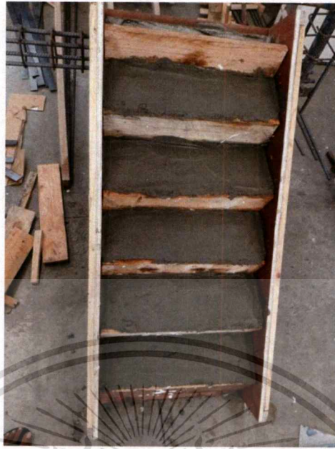
ภาพประกอบที่ 16 เทปูนในแบบที่ได้ทำไว้ทั้งเสา คาน และบันไดรูปปูนแห้งนำไปประกอบกับ ชิ้นงานหลักที่เป็นนั่งร้าน
