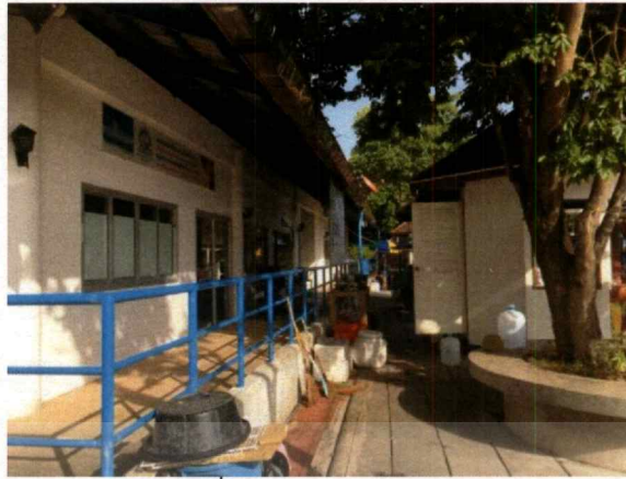
รูปที่ 2.31 ทางเดินหลังอาคาร
