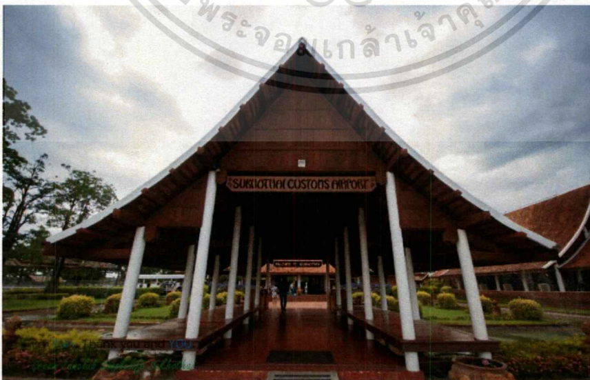
รูปที่ 2.21 ศาลาทางเข้าอาคารผู้โดยสาร
