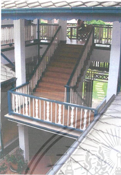
รูปที่ 1.45 บันไดเชื่อมต่อระหว่างชั้น
