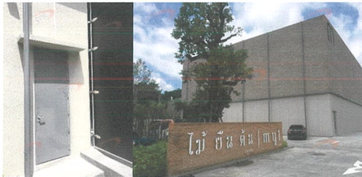
รูปที่ 1.17 ประตูเหล็กด้านนอกของโรงถ่าย (ซ้าย) อาคารโรงถ่าย 3 และ 4 (ขวา)
