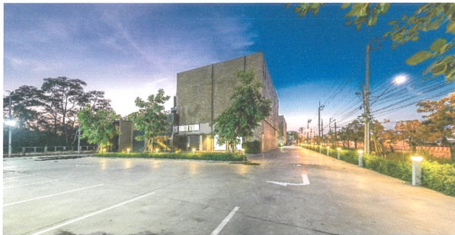
รูปที่ 1.15 ลานจอดรถบริเวณโรงถ่าย 1
