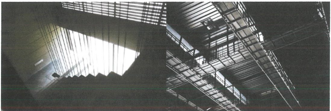
รูปที่ 1.19 บันไดขึ้นทางเดินชั้น 2 (Cat walk) และโครงสร้างฝ้าเพดานของโรงถ่าย
