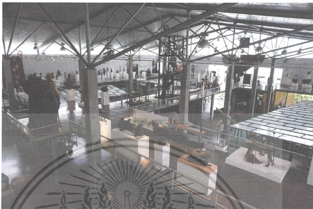
ส่วนหลังของอาคาร ใช้โครงสร้าง TRUSS ในลักษณะ ของ CARGO
