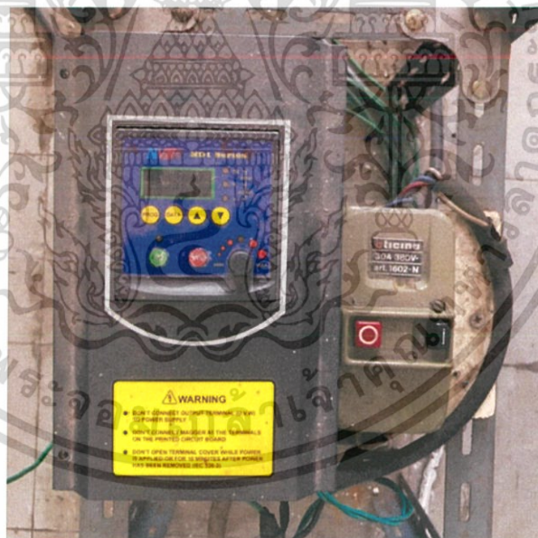
รูปที่ 4.3 อินเวอร์เตอร์ (Inverter) รุ่น ND 1 Series
