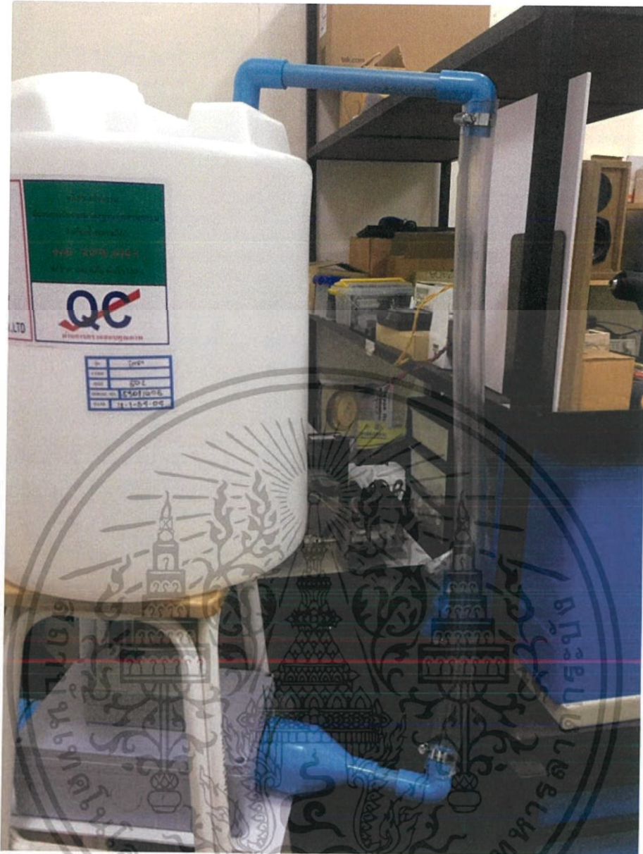
รูปที่ 3.8 การต่อท่อจากถังเก็บน้ำพลาสติก
