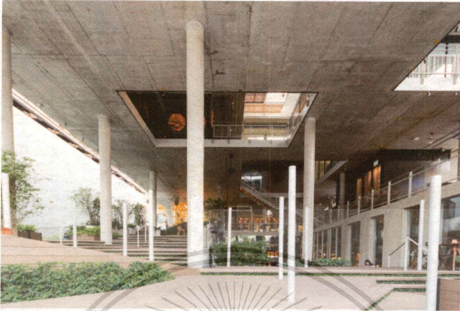
รูปที่ 1.7.1.2 มุมมองจากด้านหน้าอาคารเข้าไปในตัวอาคาร
