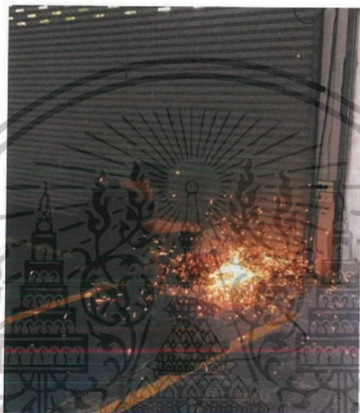
รูปที่ 3. 13 ตัดเหล็กเพื่อนำมาเชื่อมประกอบโครง
