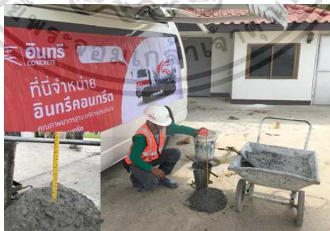
รูปที่ 4.14 การตรวจสอบทดสอบค่าการยุบตัวของคอนกรีต ทหาความชื้นเหลือของคอนกรีตภาคสนาม
