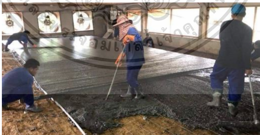
รูปที่ 3.22 ทำการเทคอนกรีตพร้อมปรับระดับคอนกรีตบริเวณที่จัดเตรียมไว้
