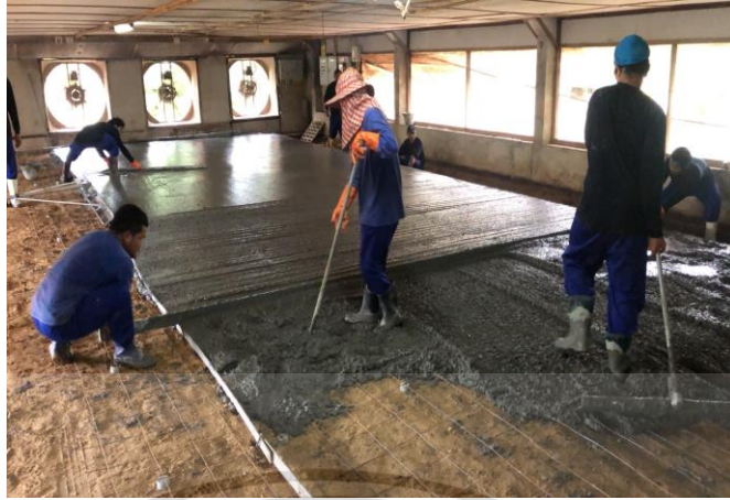
รูปที่ 4.15 เสริมลูกปูนก่อนที่จะวางตะแกรงเหล็ก Wire Mesh ทับ แล้วเทคอนกรีตลงไปให้ทั่วพื้นที่จนได้ในระดับที่ต้องการ
