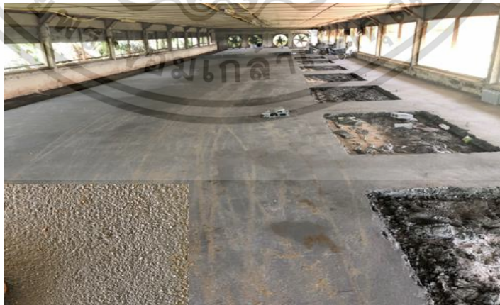
รูปที่ 4.17 ผิวคอนกรีตเริ่มแข็งตัว เข้าสู่ขั้นตอน บ่มพื้นถนนคอนกรีตด้วยจากฉีดน้ำให้ชุ่มเป็นเวลา 3-7 วัน
