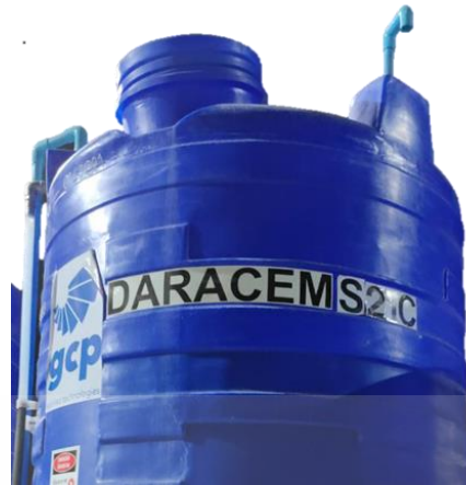
รูปที่ 3.4 Daracem S21C ประเภทประเภทลดน้ำและหน่วงการก่อตัว
