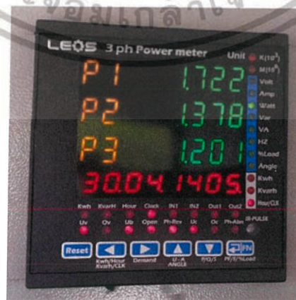
รูปที่ 3.28 มิเตอร์วัดกำลังไฟฟ้า 3 เฟส
