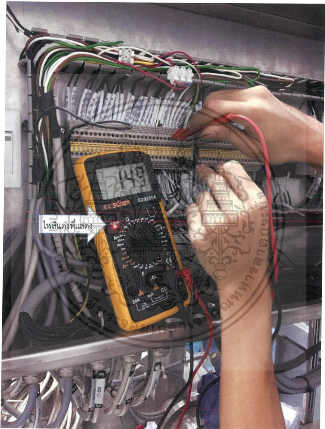
รูปที่ 3.12 ตรวจสอบรอยต่อของ Terminal
