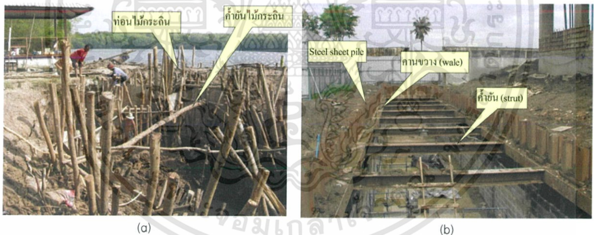
รูปที่ 2.2 ระบบกำแพงกันดิน (a) ระบบกำแพงกันดินชั่วคราวเพื่อก่อสร้างประตูระบายน้ำลึก 6 เมตร
