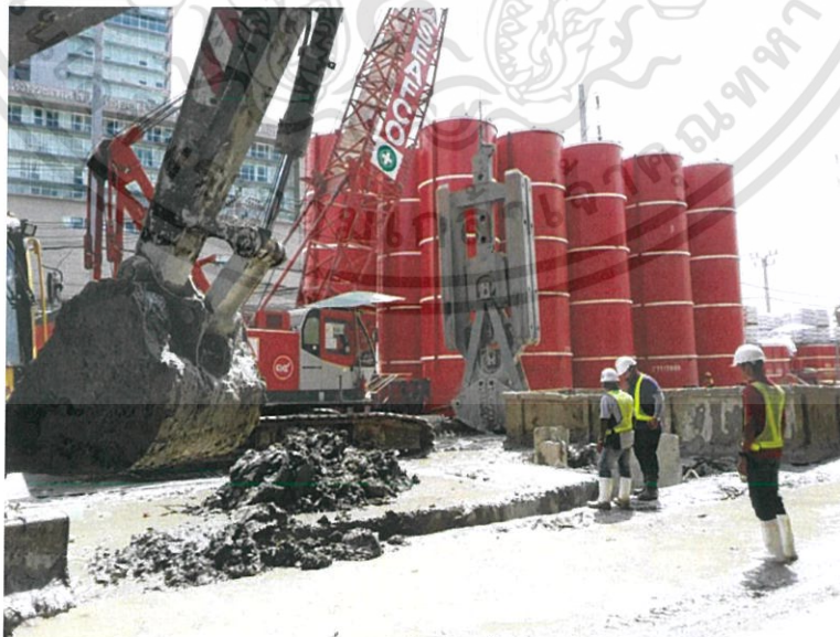
รูปที่ 2.39 ภาพขณะสำหรับเก็บสารละลายควรมีปริมาณไม่น้อยกว่า 2.5 เท่าของปริมาณที่ใช้เจาะ
