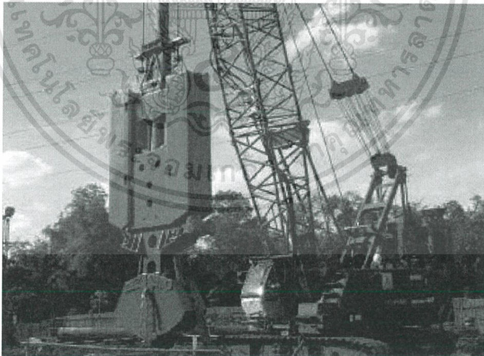
รูปที่ 2.22 หัวเจาะกำแพงกันดินชนิดขุดและหล่อในที่ (กมล สิงโตแก้ว, คณะ)
