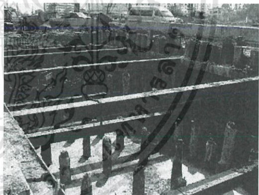
รูปที่ 2.13 กำแพงเสาเข็มชนิดเจาะเรียงขบชิดกัน (Secant Bored Pile) (ชาญชัย ทรัพย์มณีวงศ์)
