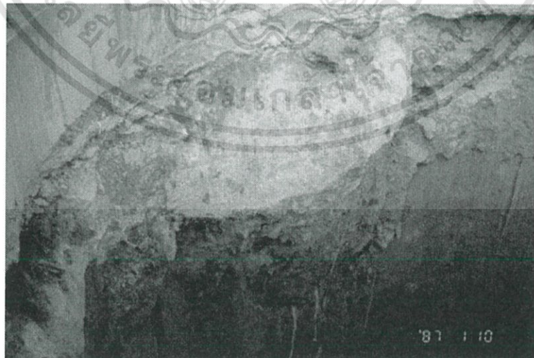
รูปที่ 2.36 ผนังบวมปูดที่ได้ระดับ Guide Wall (ณรงค์ และคณะ)
