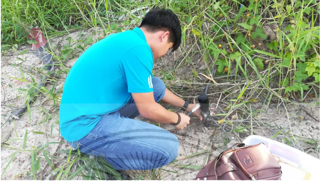
รูปที่ 7-9 การติดตั้งหมุดวัดแรงสั่นสะเทือน
