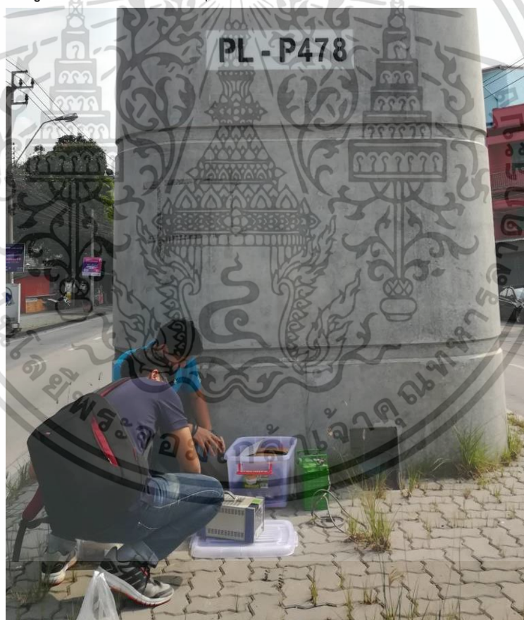
รูปที่ 7-12 การติดตั้งอุปกรณ์กับฐานเสาธงไฟฟ้า
