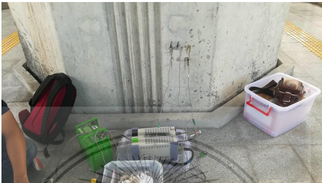
รูปที่ 7-11 การติดตั้งอุปกรณ์วัดความแรงกับเสาธงไฟฟ้า BTS
