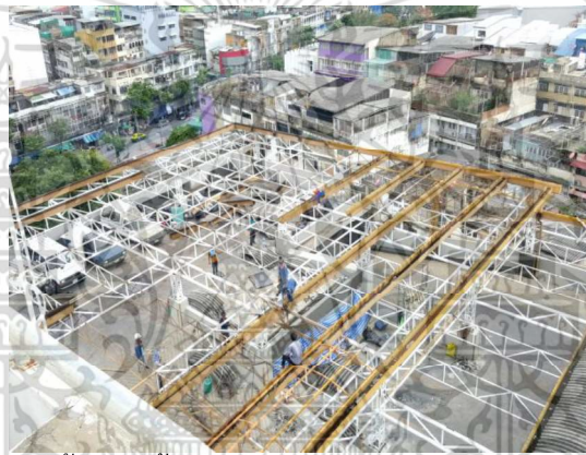
รูปที่ 3.1 พื้นที่ติดตั้งเซลล์แสงอาทิตย์บนดาดฟ้าอาคารจอดรถ
