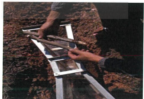
รูป 3.15 ขณะเตรียมไม้สำหรับตอกเป็นเสาเข็ม
