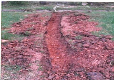
รูป 3.14 ขุดดินทำทางน้ำ
