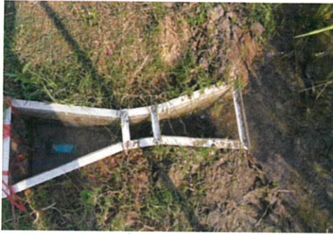
รูป 3.16 ปล่องน้ำผ่าน Parshall Flume
