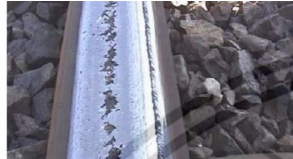
เนื้อหลุดร่อนและแตกเป็นเส้นที่หัวราง (Flaking with Head Checking)
