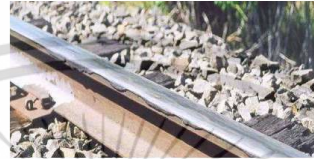
การเสียรูปของราง (Rail plastic flow)
