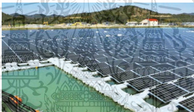
รูปที่ 2.9 ตัวอย่างระบบเซลล์แสงอาทิตย์บนผิวน้ำ (Floating solar system) [28]
