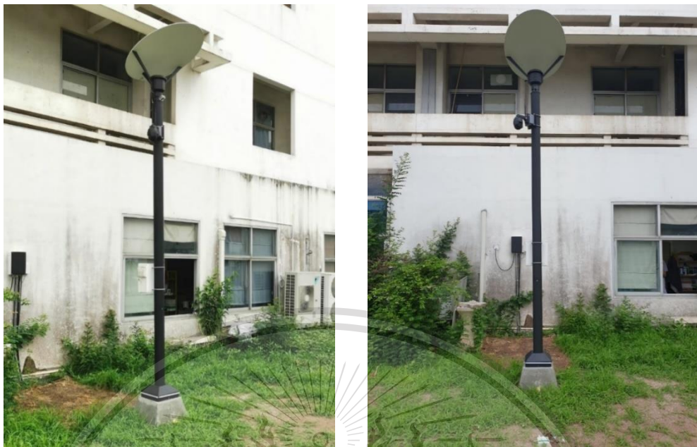
รูปที่ 4.1(ข) ภาพรวมการติดตั้งของเสาต้นหลัก
