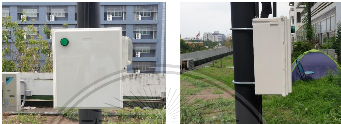
รูปที่ 4.7 การติดตั้งกล่องควบคุม
