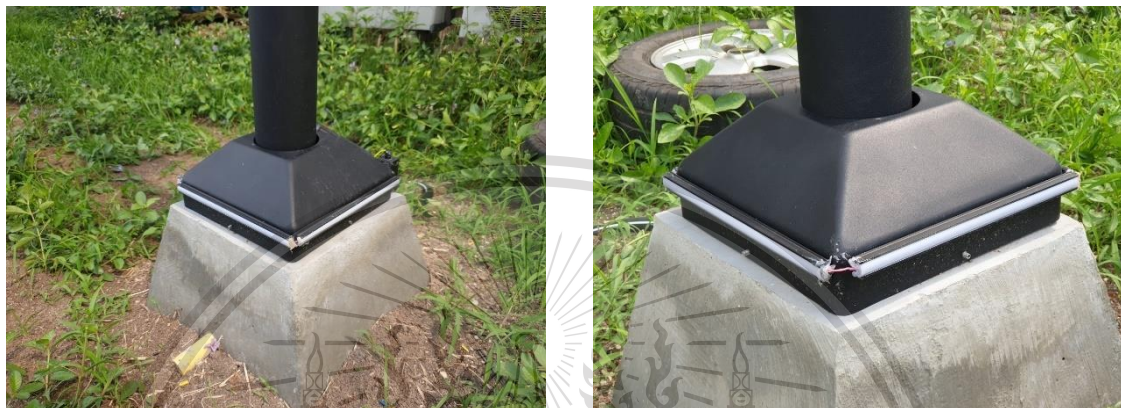
รูปที่ 4.9 การติดตั้งไฟแอลอีดีที่ฐานเสา
