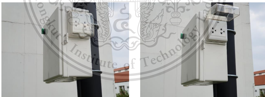
รูปที่ 4.8 การติดตั้งตัวรับบนกล่องควบคุม
