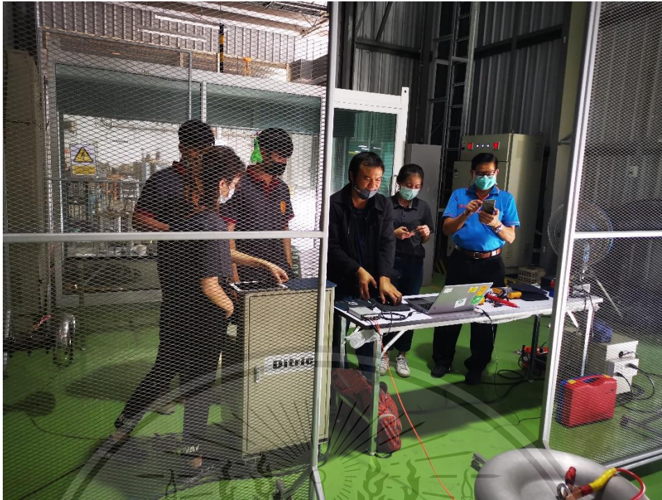
รูปที่ ค.5 วางแผนการทดสอบสายเคเบิลใต้ดินโดยการวัดดิซซาร์จบางส่วนด้วยเทคนิค Synchronous Multi-channel
